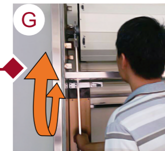
G Thiết kế cơ lê giúp điều chỉnh nhanh chóng độ chặt lỏng của lò xo mà không cần mở nắp đóng
